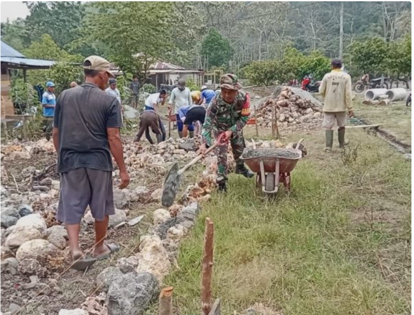
Gotong royong bangun pondasi rumah warga
